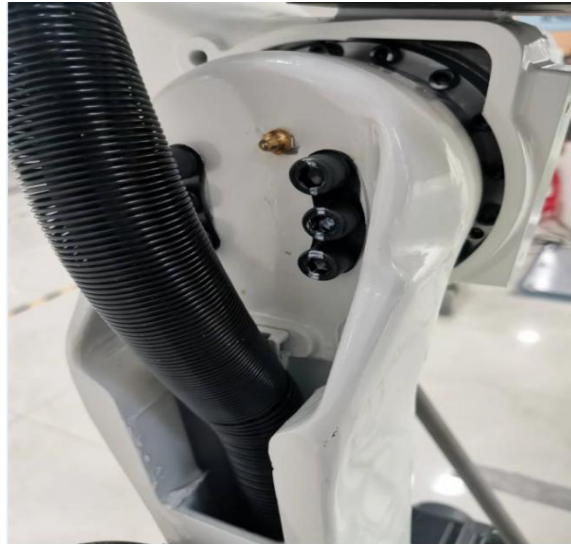
图 4.1 本体线缆防护检查
